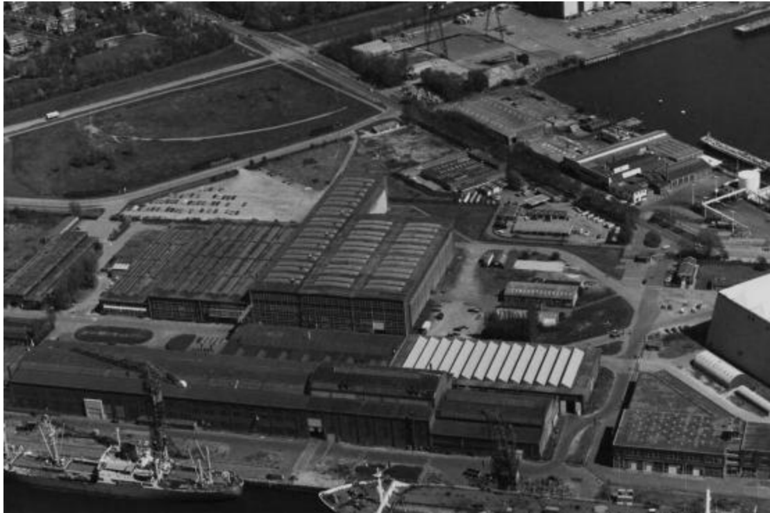
Een opname van het gebouw in 1984 - Opname afkomstig uit het Stadsarchief Rotterdam
