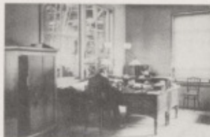
DE DIRECTIEKAMER ONGEVEER 1902
