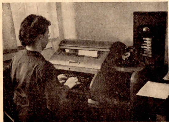
Foto 3. De telexmachine bij een van de werven. Op ontvangen berichten wordt een etiketje geplakt met de naam van de afzender. Voor elke werf heeft het etiketje een aparte kleur
